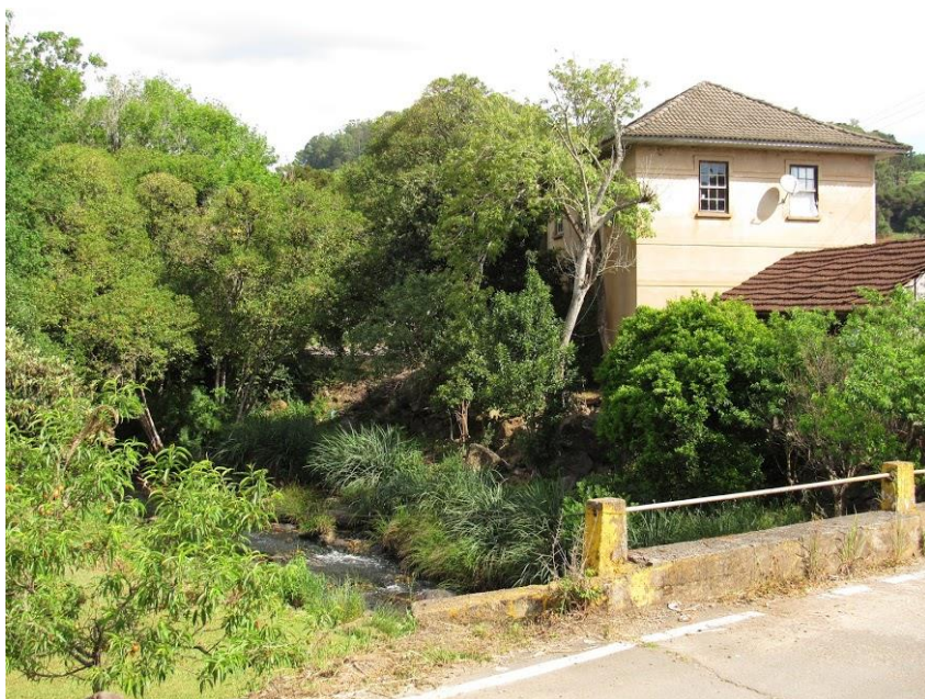
O rio que transbordava com as chuvas fortes. (imagem atual – Rogério Machado)
